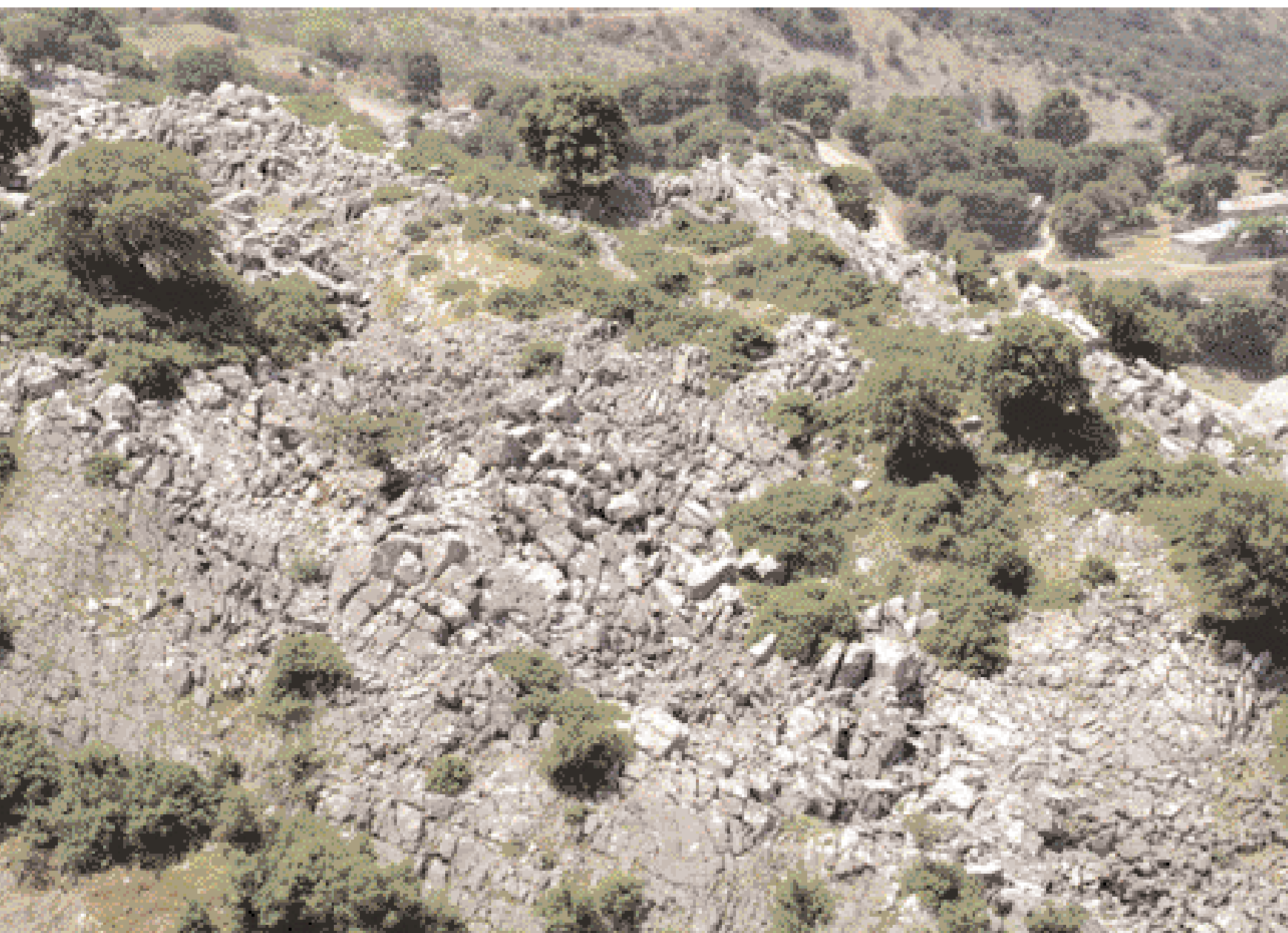
Άψογη φυσική λιθοδομή για τη στήριξη της πλαγιάς του λόφου.
