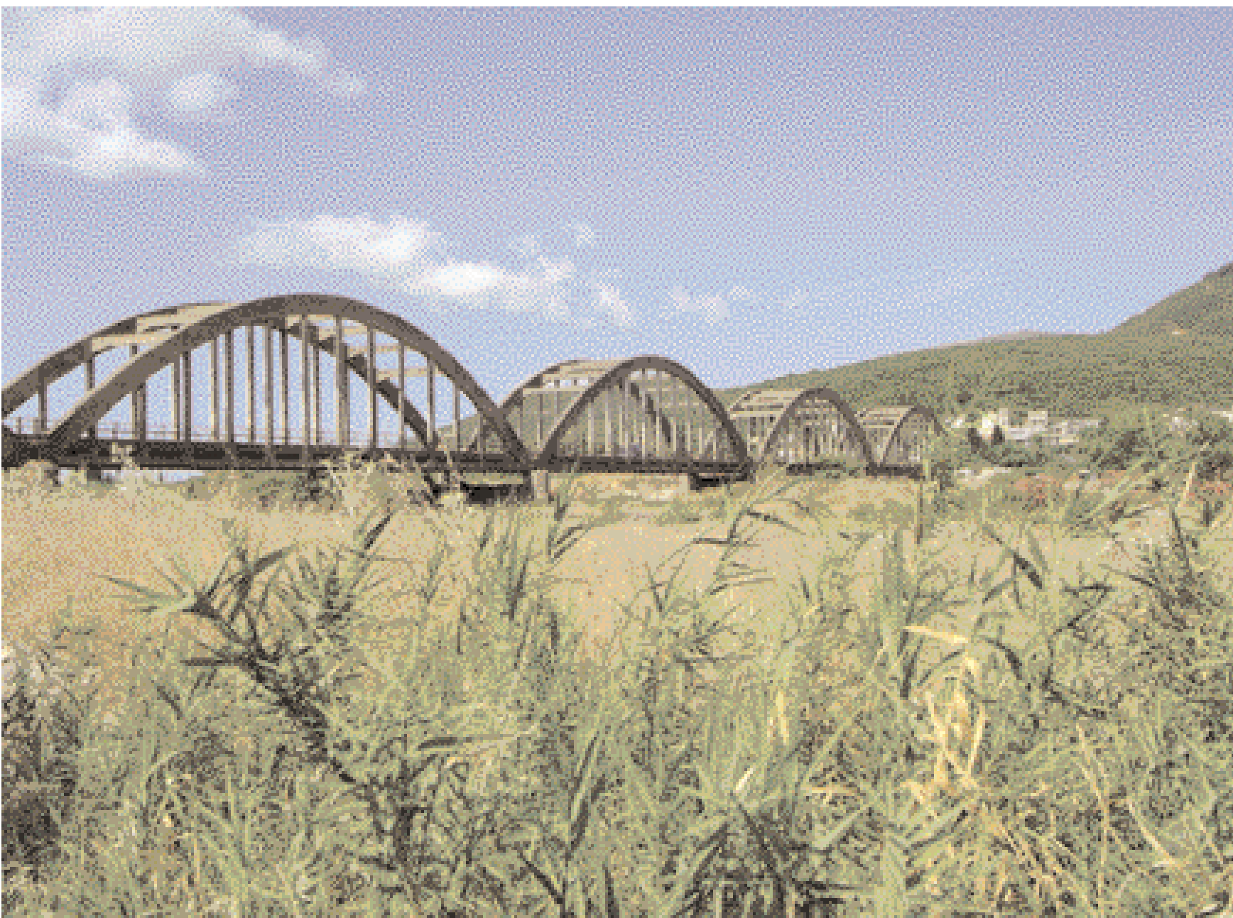
Η γέφυρα του Μόρνου με τα πέντε τόξα που ενώνει τη Ναυπακτία με τη Δωρίδα.
