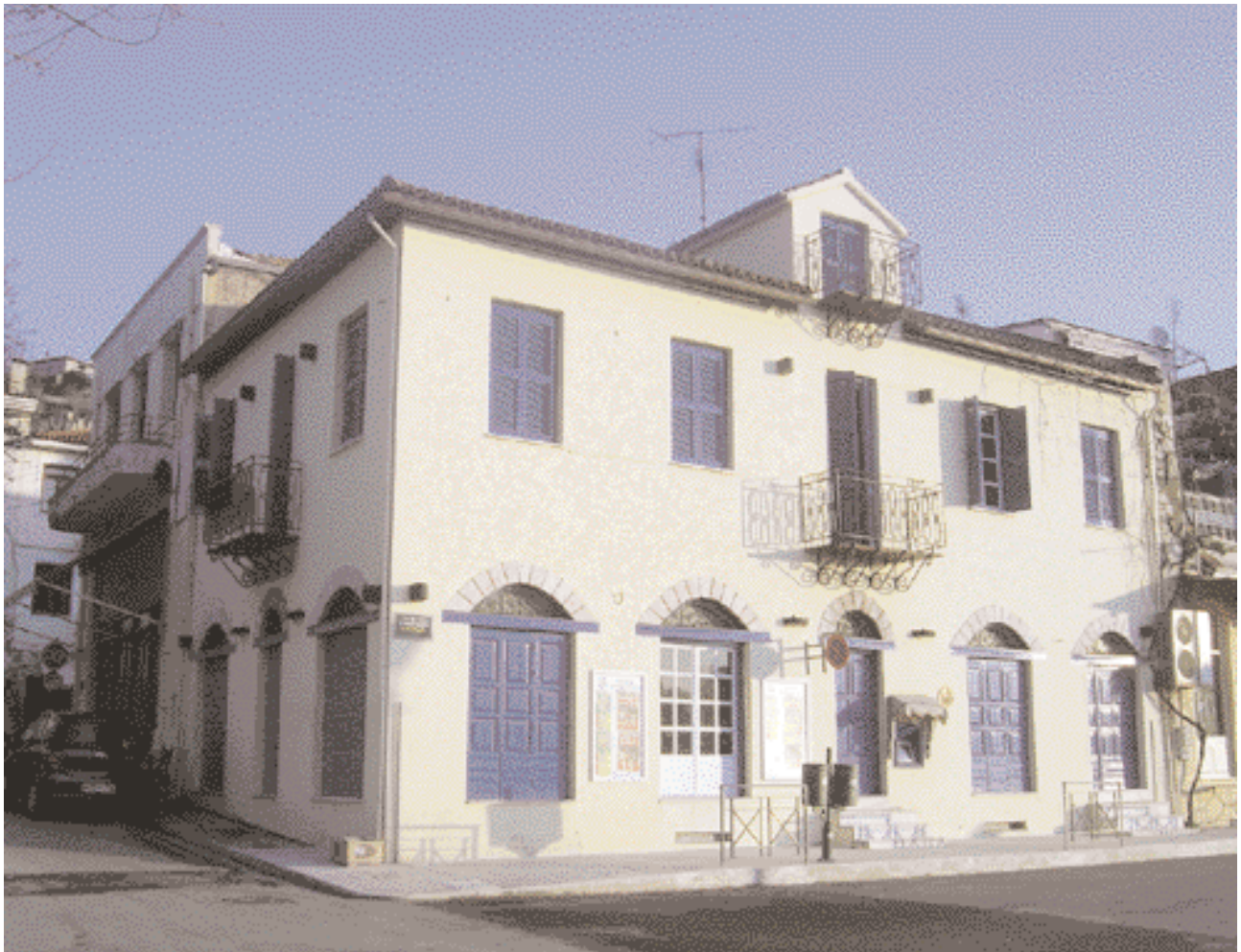
Το δημοτικό κτίριο «ΝΑΥΠΑΚΤΙΑ» όπου γίνονται εκθέσεις εικαστικών τεχνών, βιβλίων κ.ά.
