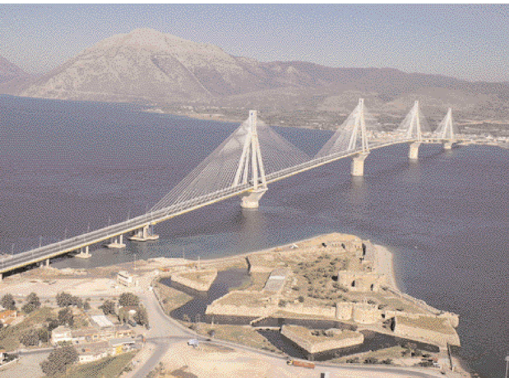
Η γέφυρα Ρίου-Αντιρρίου.
