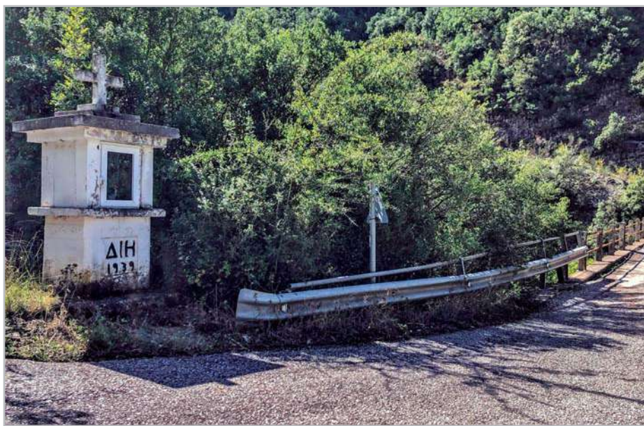
Παλιό εικόνισμα από μπετόν στη γέφυρα του Πόρου αφιερωμένο στην Αγία Αικατερίνη. Ανεγέρθηκε το 1939 συγχρόνως με την κατασκευή της γέφυρας από τον κατασκευαστή της γέφυρας, Δημήτριο Ι. Ηλιόπουλο.
