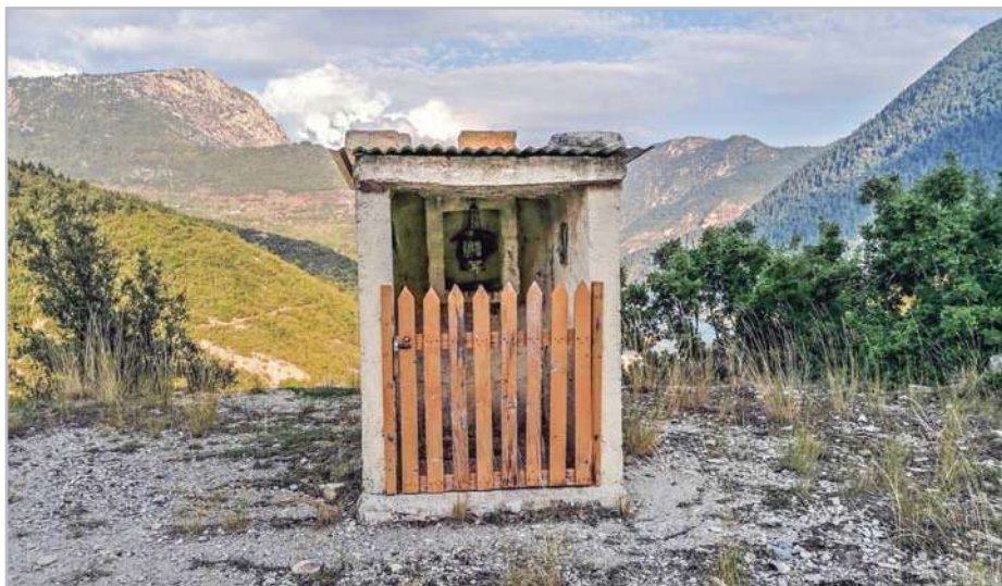
Εικόνισμα ασυνήθιστης κατασκευής βρίσκεται στην παραλίμνια οδό, ανατολικά του χωριού Περδικόβρυση Ναυπακτίας, στον επαρχιακό δρόμο προς Άγιο Δημήτριο. Το εικονοθέσιο χωρίς βάση μοιάζει να αιωρείται αφού στηρίζεται μόνο στην εσωτερική πλευρά του κτίσματος.
