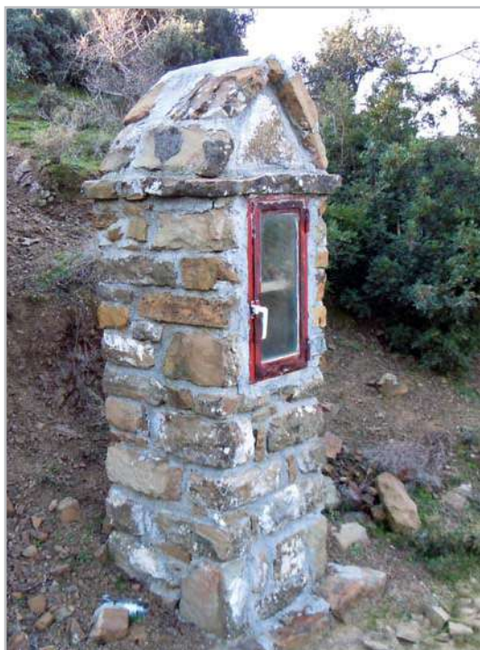
Στη Ρίζα, στο 3ο χιλιόμετρο του δρόμου Ρίζας – Καλαβρούζας, στη θέση Παλιάλωνο, υπάρχει πετρόκτιστο εικόνισμα αφιερωμένο στον Άγιο Αθανάσιο. Ανεγέρθηκε στα τέλη της δεκαετίας του 1890 από Νιοκαστρίτες ποιμένες που μετοίκησαν στη Ρίζα.
