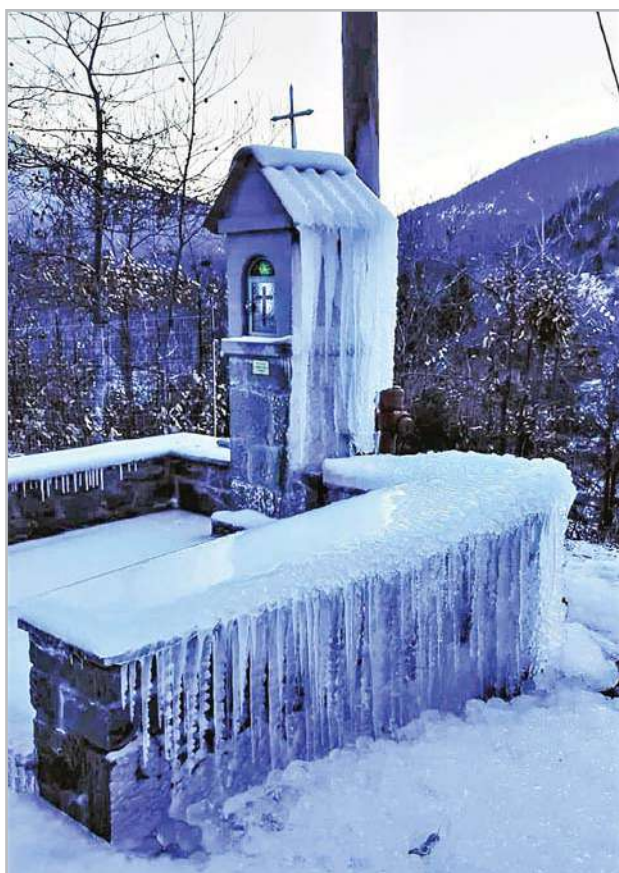
Εικόνισμα κάτω από την ψυχρή πνευλιά της φύσης, στην Άνω Χώρα. (Φωτογραφία Πάνος Τσουνκαλάς, Χειμώνας 2020).
