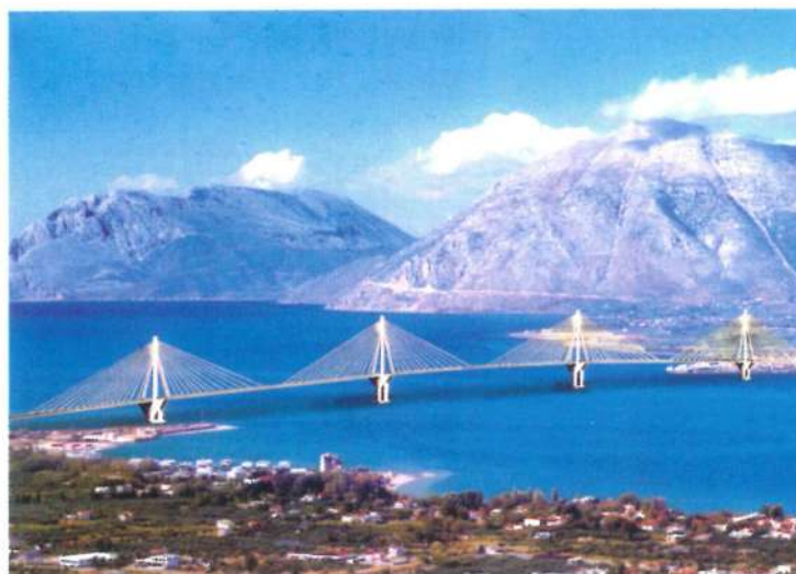
Η γέφυρα Ρίου - Αντιρρίου
